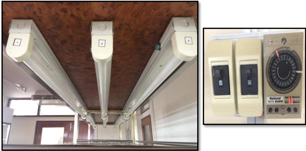
รูปที่ 4.26 ชั้นสำหรับวางขวดเพาะเลี้ยง (culture shelf) ที่ติดหลอดฟลูออเรสเซนต์ (Fluorescence lamp) และนาฬิกาควบคุมเวลาการปิดเปิดหลอดไฟฟ้า
