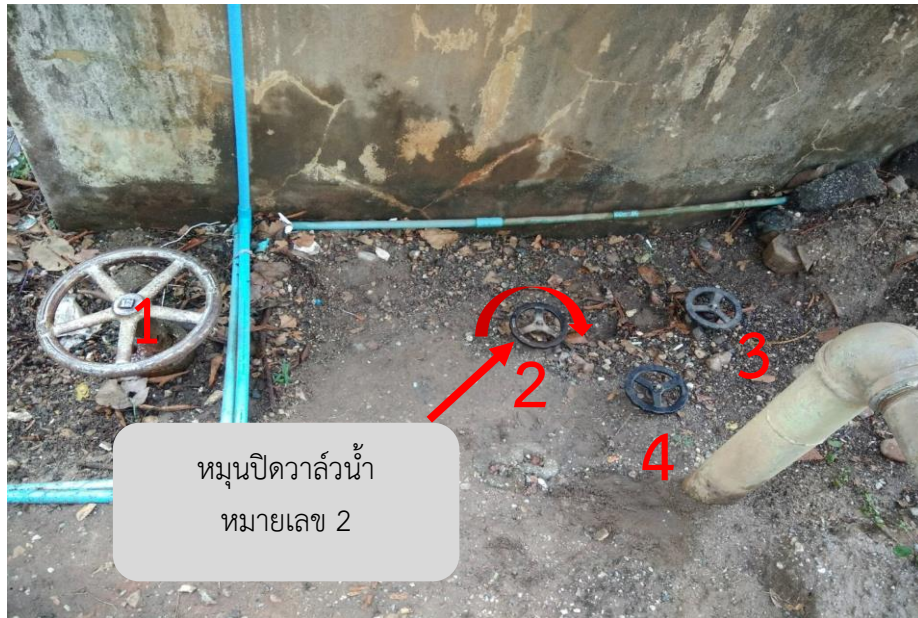
ภาพที่ 4.19 วิธีปิดวาล์ว หมายเลข 2
