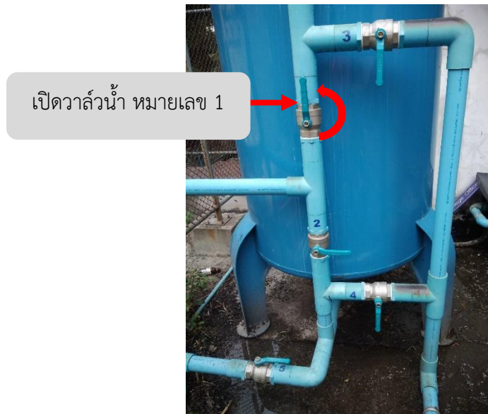
ภาพที่ 4.31 วิธีเปิดวาล์วหมายเลข 1
