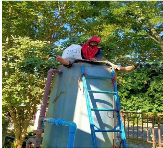
ภาพที่ 4.50 วิธีการบรรจุสารกรองน้ำชนิดกรวด
