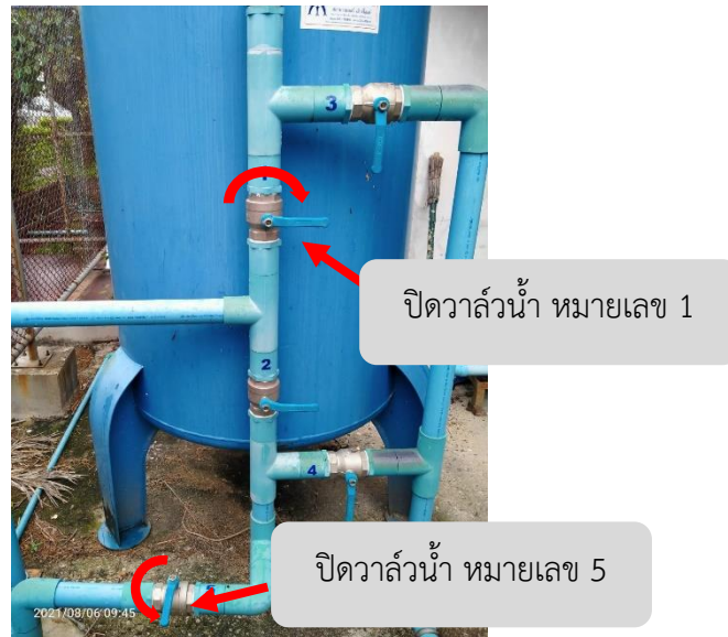
ภาพที่ 4.27 วิธีปิดวาล์วหมายเลข 1 และหมายเลข 5
