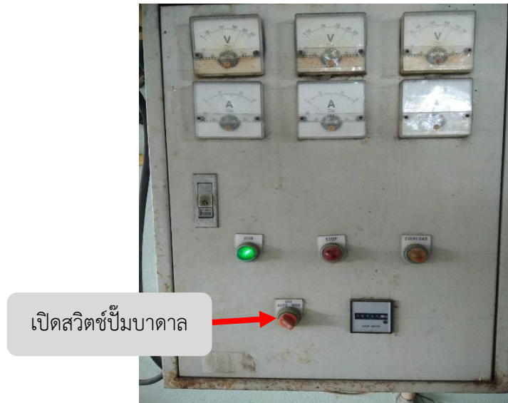
ภาพที่ 4.9 การแสดงสถานะการทำงานของตู้คอนโทรลควบคุมปั้มน้ำบาดาล
