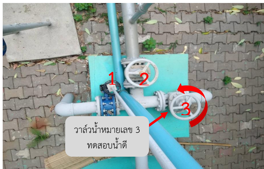
ภาพที่ 4.10 วิธีเปิดวาล์วหมายเลข 3
