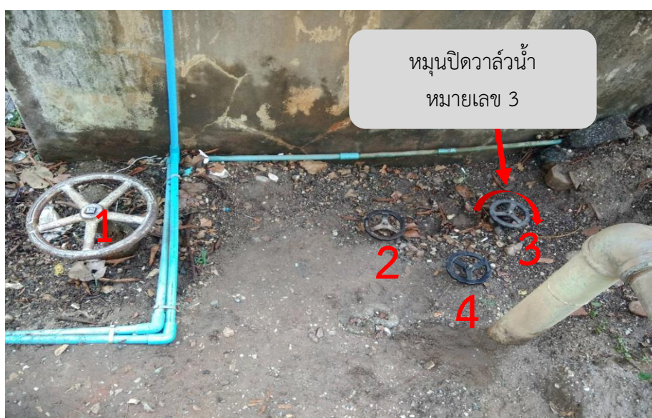
ภาพที่ 4.24 วิธีปิดวาล์ว หมายเลข 3
