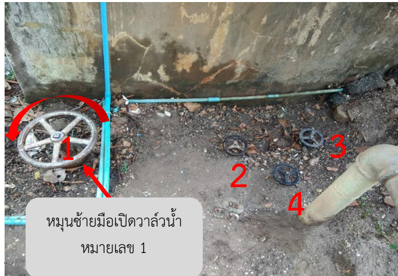
ภาพที่ 4.15 วิธีเปิดวาล์วหมายเลข 1
