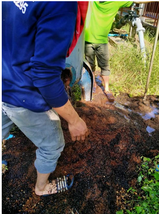
ภาพที่ 4.48 วิธีการล้างสารกรองน้ำเก่าออกจากถังกรอง
