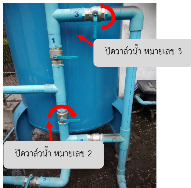
ภาพที่ 4.30 วิธีปิดวาล์วหมายเลข 2 และ หมายเลข 3
