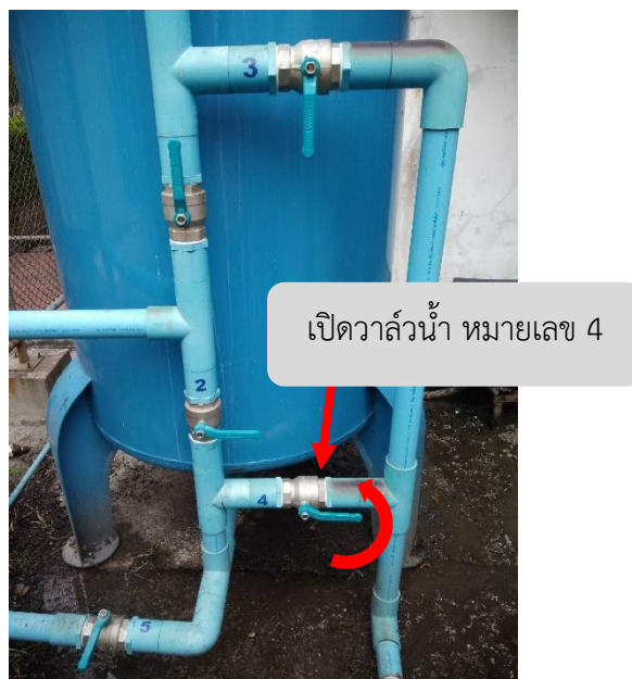
ภาพที่ 4.32 วิธีเปิดวาล์วหมายเลข 4
