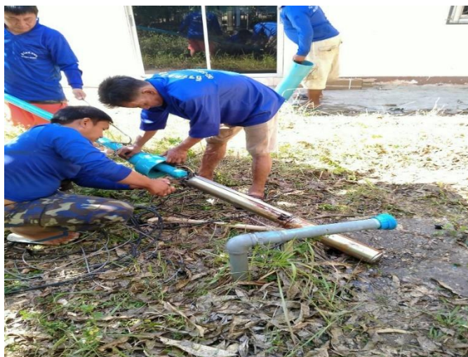
ภาพที่ 4.60 การตรวจเช็คใบพัดและมอเตอร์ปั้มน้ำ
