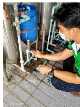
รูปหลังซ่อม
