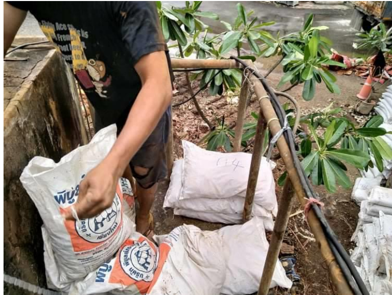
ภาพที่ 4.38 วิธีการลงกรวดกรองน้ำ
