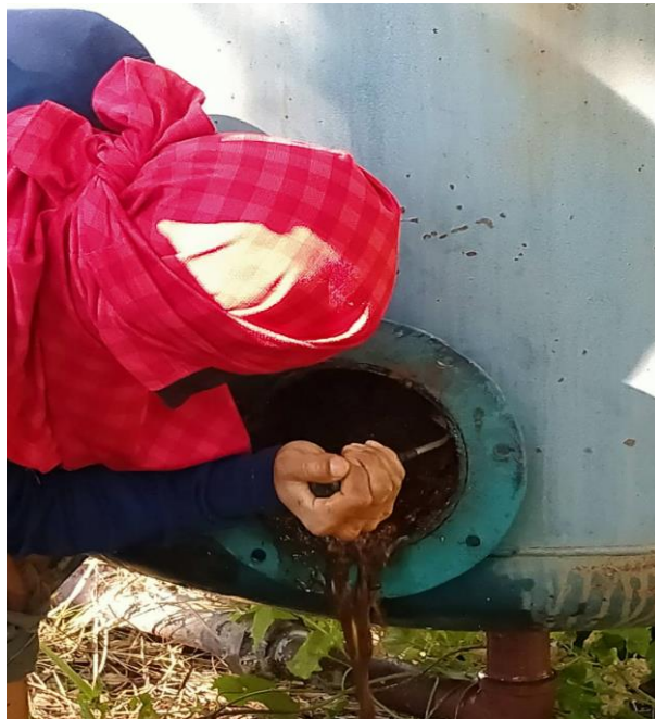
ภาพที่ 4.47 วิธีการกระแทกเอาสารกรองออก
