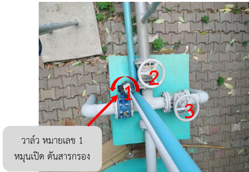
ภาพที่ 4.5 วิธีเปิดวาล์วน้ำหมายเลข 1
