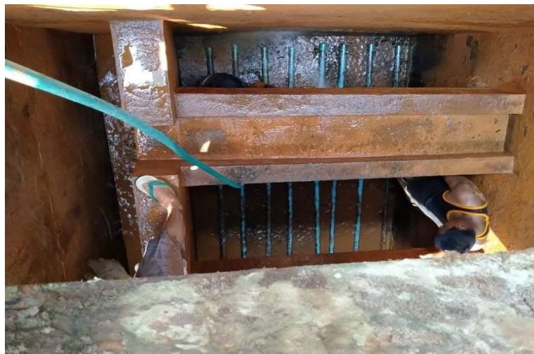
ภาพที่ 4.37 ทำความสะอาดถังกรองน้ำและหัวกรองน้ำ
