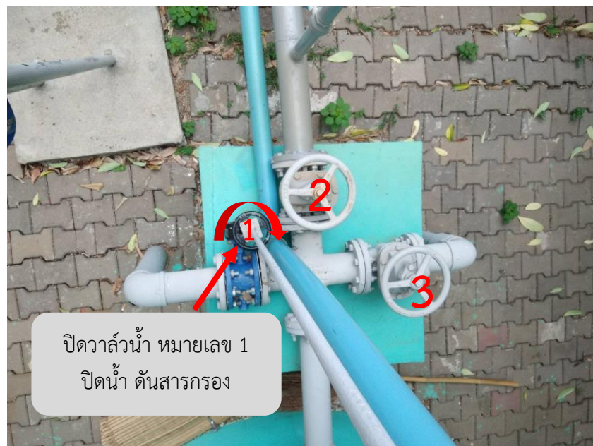
ภาพที่ 4.8 วิธีปิดวาล์วน้ำ หมายเลข 1
