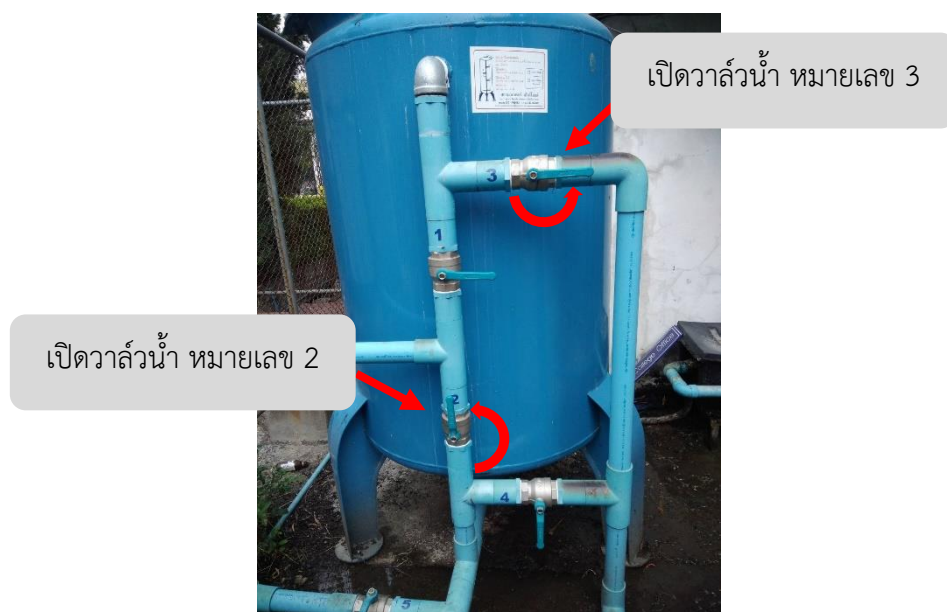
ภาพที่ 4.28 วิธีเปิดวาล์วหมายเลข 2 และหมายเลข 3
