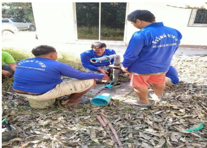
ภาพที่ 4.61 การเชื่อมระบบท่อปั้มน้ำบาดาล
