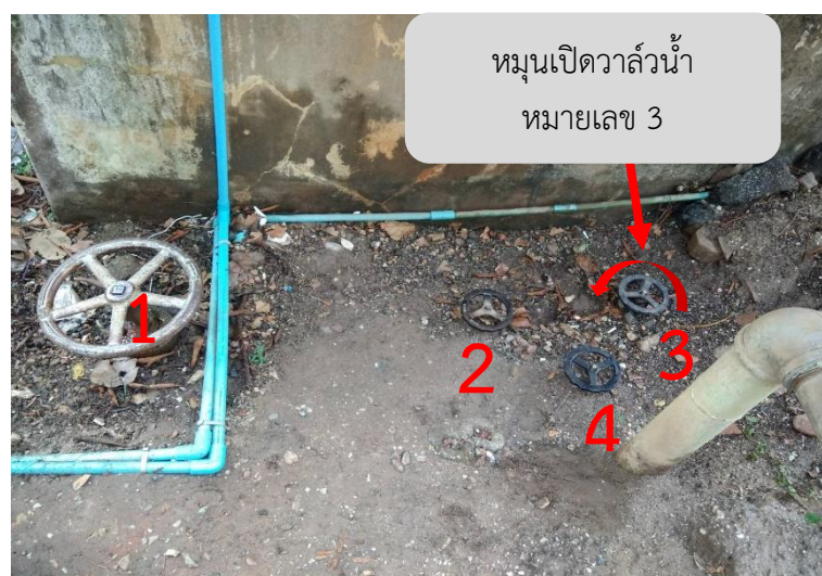
ภาพที่ 4.22 วิธีเปิดวาล์วทดสอบระบบกรองน้ำ
