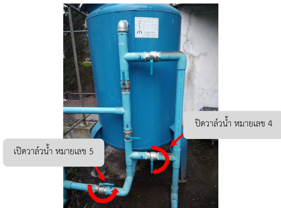
ภาพที่ 4.34 วิธีเปิดวาล์วหมายเลข 5 และปิดวาล์วหมายเลข 4
