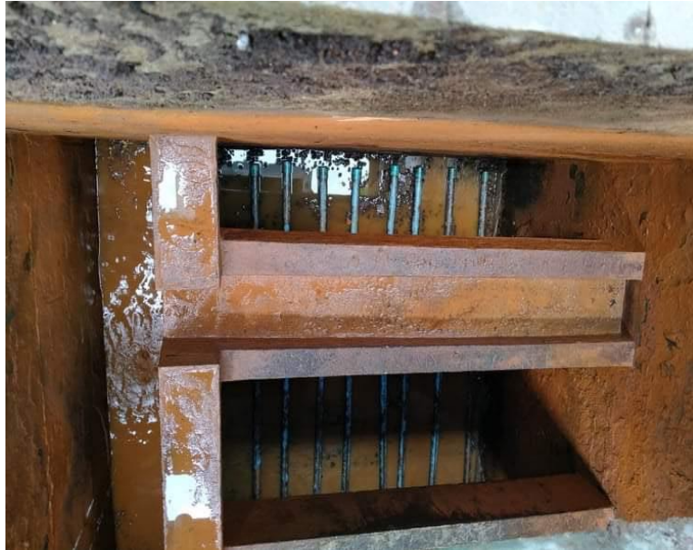
ภาพที่ 4.36 หัวกรองน้ำแบบท่อถังปลาหรือแบบแขน (Arm)
