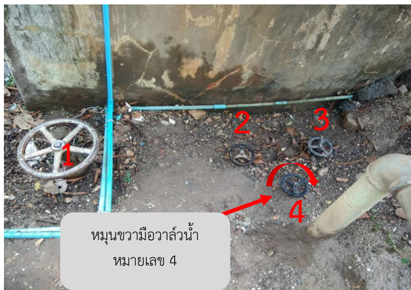
ภาพที่ 4.16 วิธีปิดวาล์วหมายเลข 4
