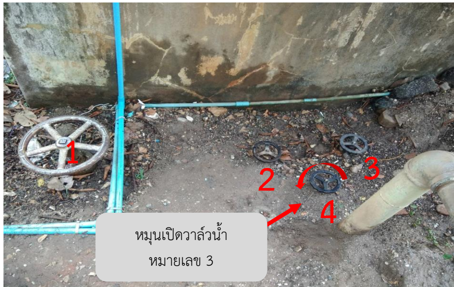
ภาพที่ 4.25 วิธีเปิดวาล์ว หมายเลข 3
